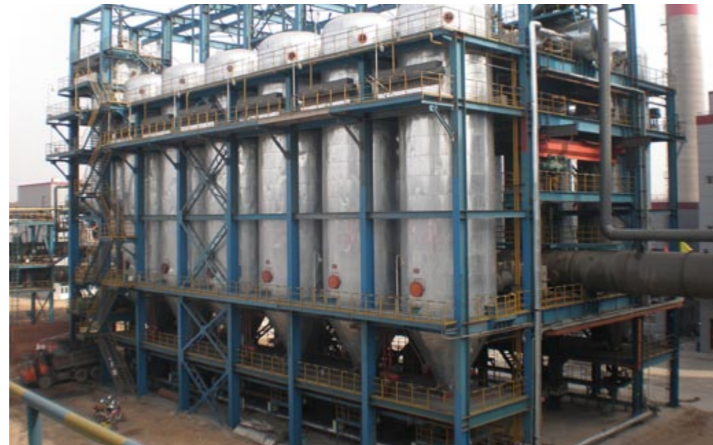
宣钢10号2500m 3 高炉煤气干法除尘系统总承包工程
